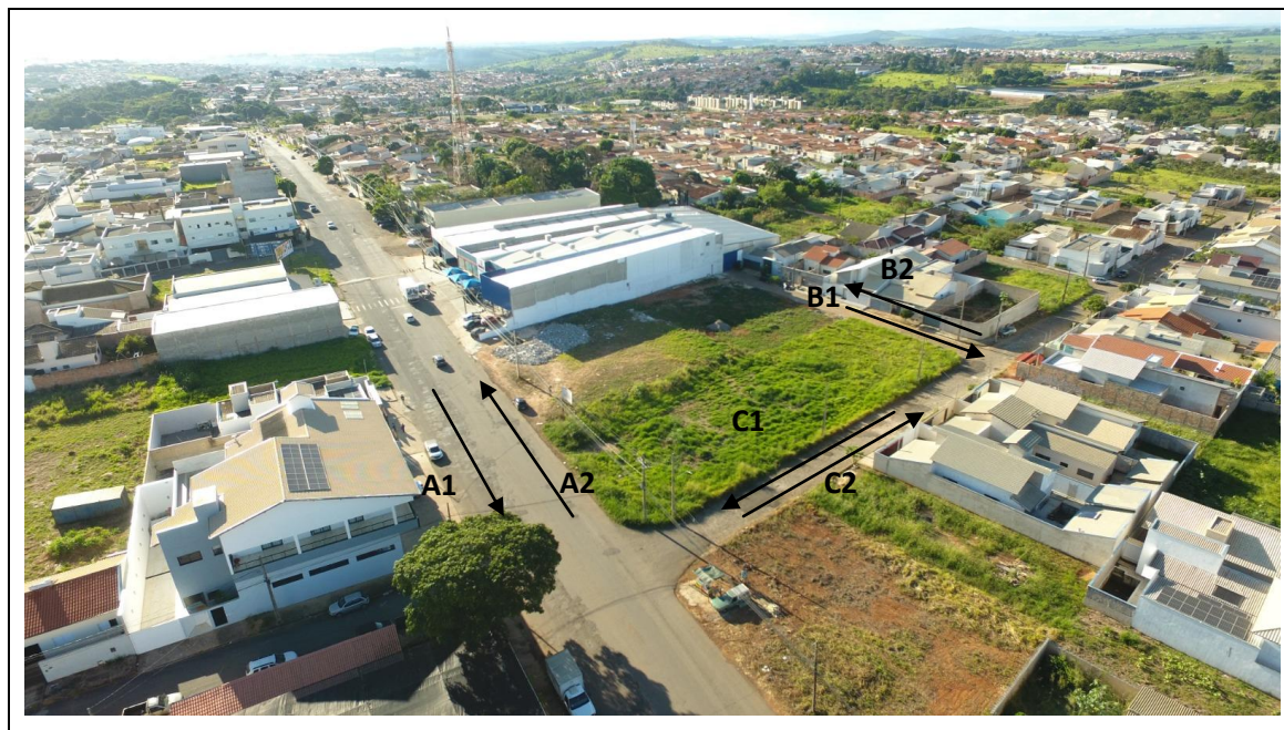
Figura 21 – Fluxos analisados in loco na contagem de veículos.
